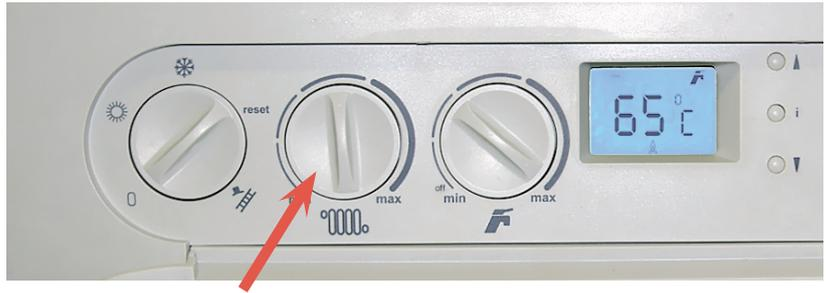
**При активированном эквитермном регулировании изменяется значение функции среднего вращательного регулятора на панели управления котла. Указанным регулятором в этом случае устанавливается сдвиг кривой отопления (в диапазоне  $\pm 15^\circ\text{C}$  от установленной сервисным техником эквитермной кривой).**
